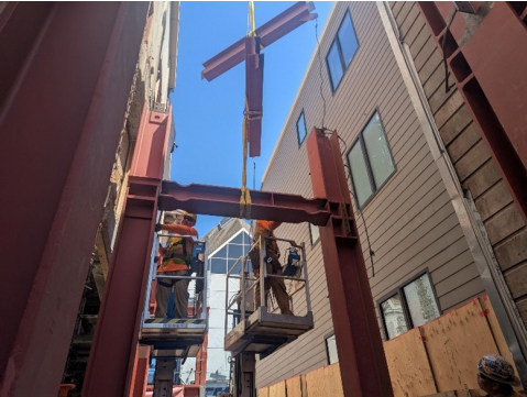
Steel delivery. Entrega de acero.
