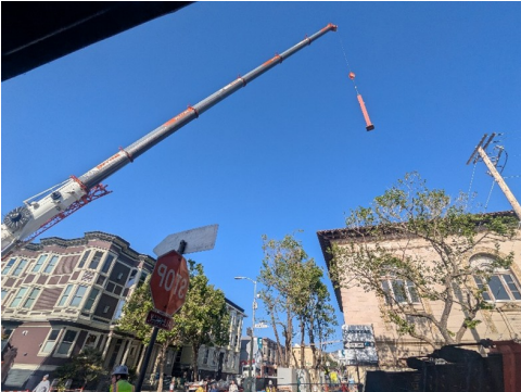
Steel delivery. Entrega de acero.
